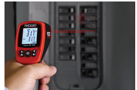
ヒューズや回路遮断器が過熱していないか調べます。過熱していれば回路の過負荷が疑われます。
